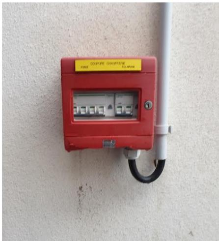
A proximité de la chaufferie de l'école est installé un coffret qui permet de couper l'alimentation électrique de celle-ci en cas d'incident grave. Ce coffret a été dégradé, gratuitement, à deux reprises, entraînant un arrêt de la chaudière en pleine puissance et la détérioration d'un capteur de sécurité. Deux incivilités qui coûtent plus de 500 € à la collectivité.
